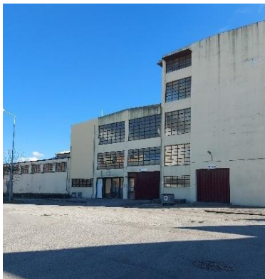
Edificado (Parque Estarreja)
