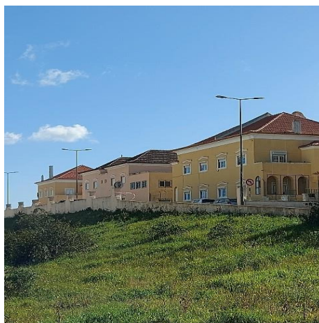
Arranjos Exteriores (Parque Barreiro)
